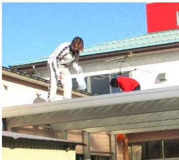
屋根の上の落ち葉取り
