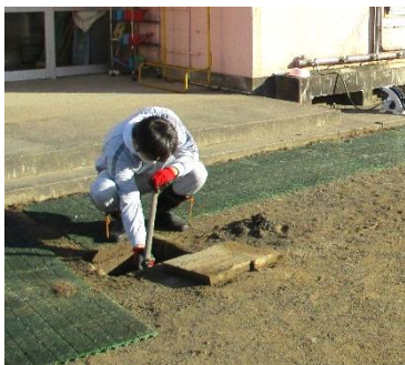
排水溝の落ち葉や泥出し
