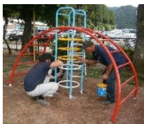
(鉄の腐食部分補強 錆び落とし他)
