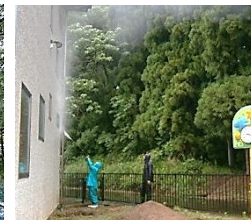
園舎壁高圧洗浄
